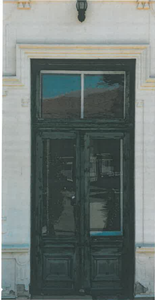
KÜLSŐ HOMLOKZATI KÉP
